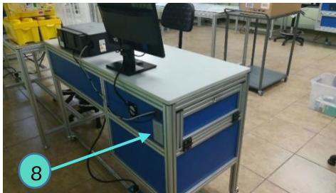
Fig. 46 Contacto Eléctrico a 110 VCA
