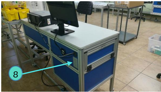
Fig. 59 Contacto Eléctrico a 110 VCA
